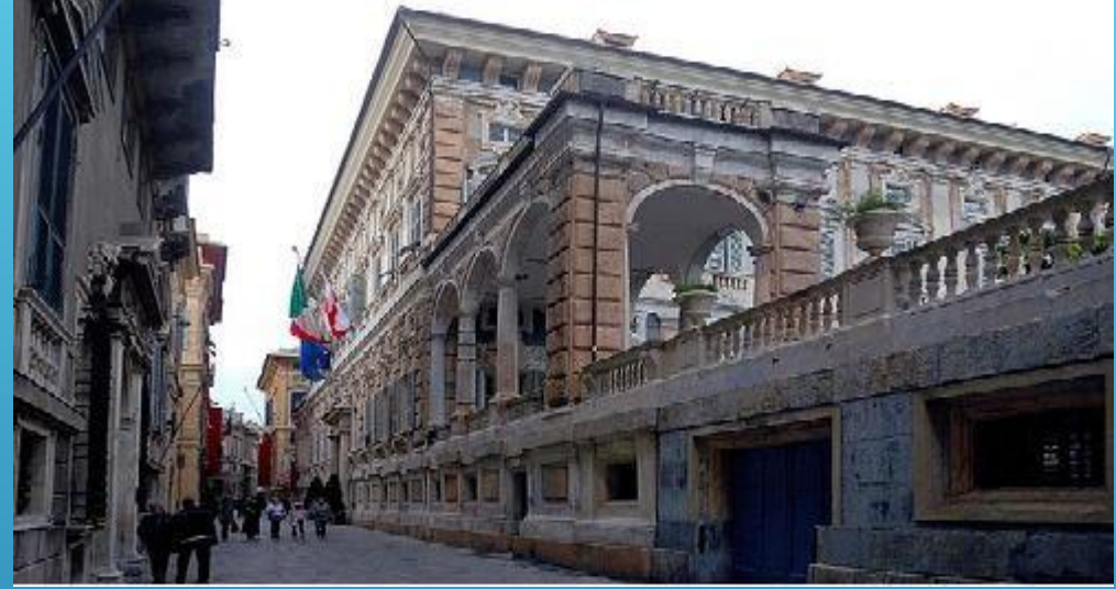
Instituto Comprensivo Di Cogoleto, Genua. Le Strade Nuove, Palazzi dei Rolli
